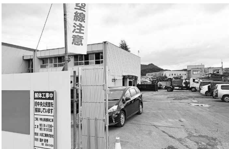
▲解体が進められている中央公民館
