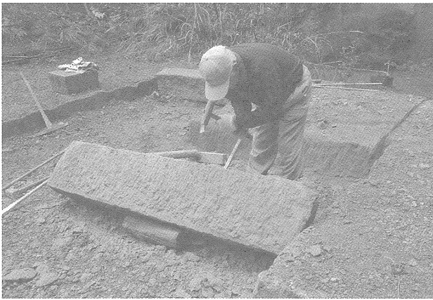
「ウラ」最後の縁入れ作業
