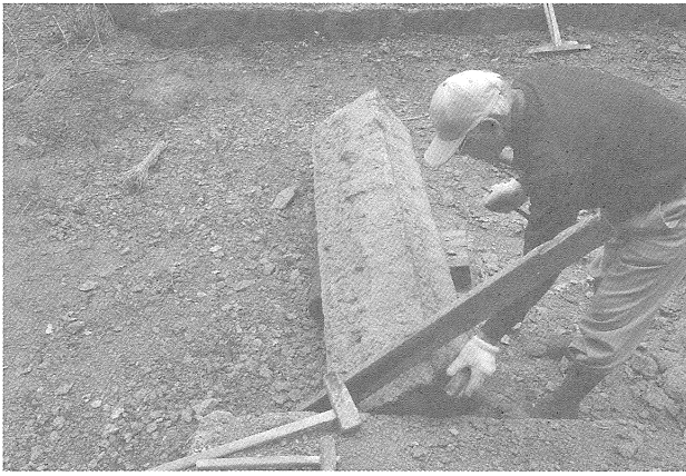
墨付け作業（同時に反りを見ている）
