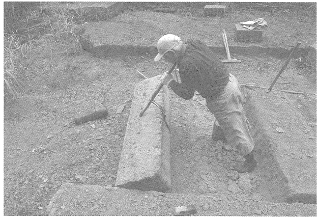
⑩の作業が終わり石を回転させている
