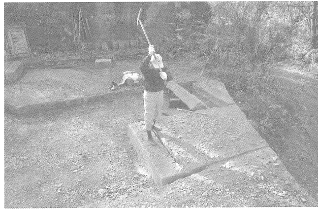
ホッキリヅルによる溝掘り
