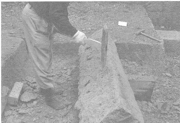
「ツラ」面のツル削り
