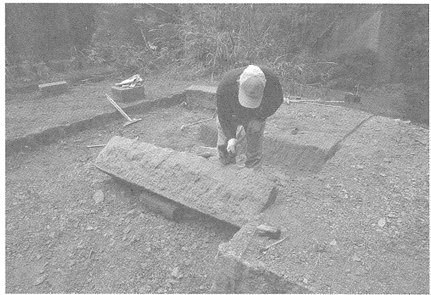
鋸歯状にはみ出した部分の除去
