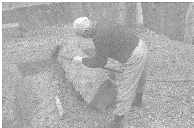
ゲンノウによるコツラの調整
