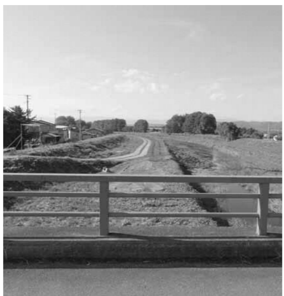
▲工事が進む屋代川
