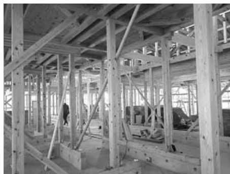
▲建設が進む亀岡地区公民館
