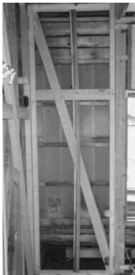
▲耐震化のための筋かい補強
