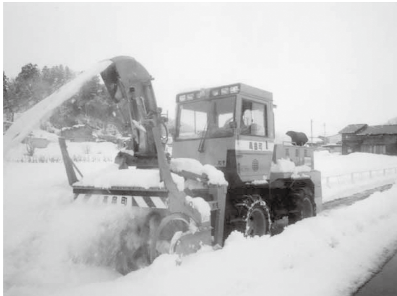
▲間口への押し雪に配慮した除雪を
