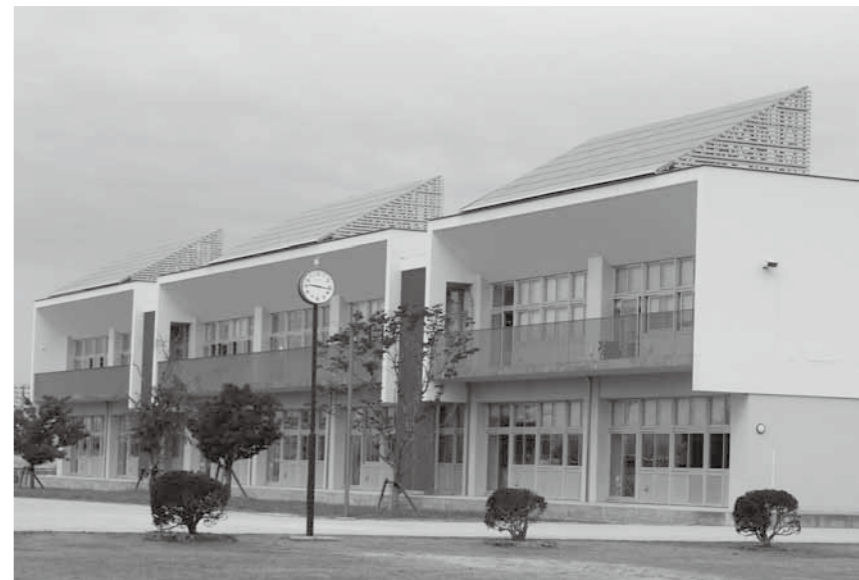
▲公共施設に設置されたソーラーパネル（高島中学校）
