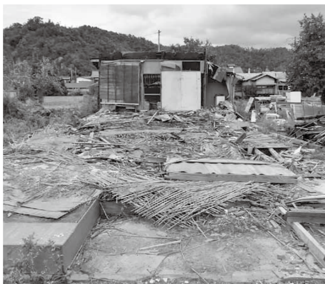
▲住民の手で解体された危険家屋
