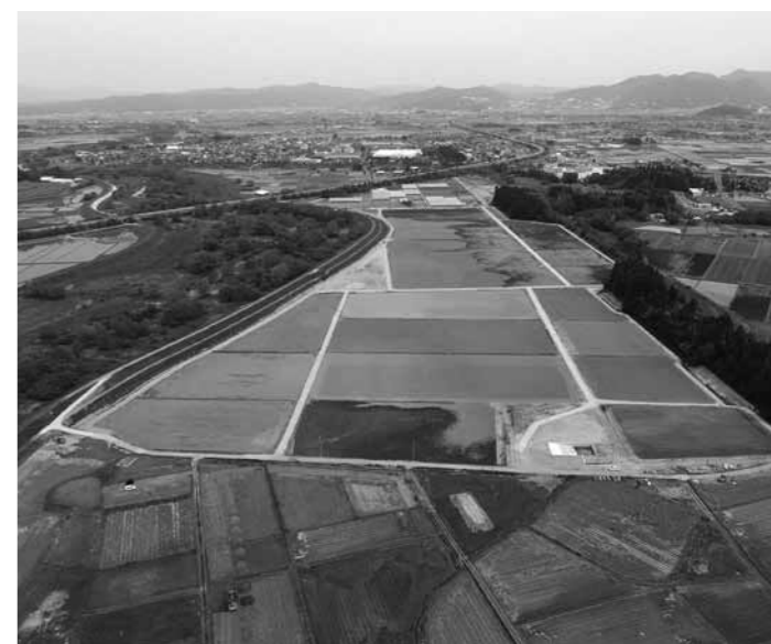
▲亀岡西地区 ほ場整備
