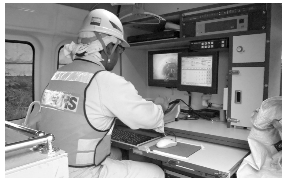
▲下水道管内部のカメラによる状況確認
