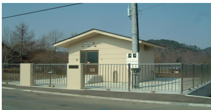
太田送水ポンプ場
