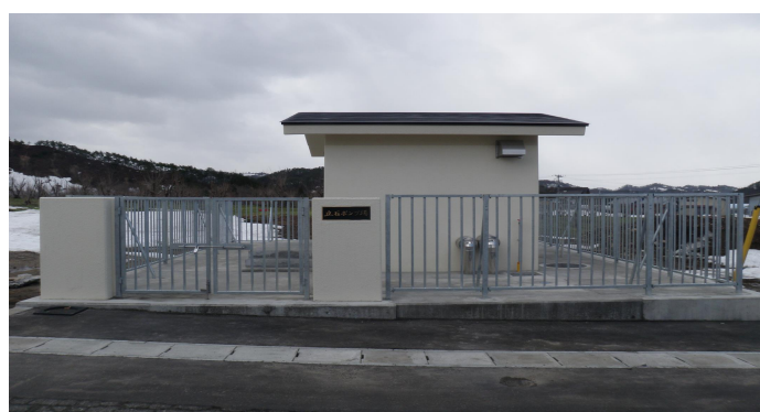
立石ポンプ場
