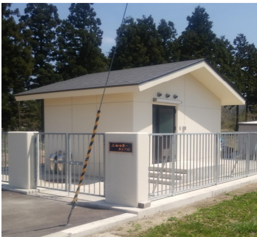
上和田第1送水ポンプ場
