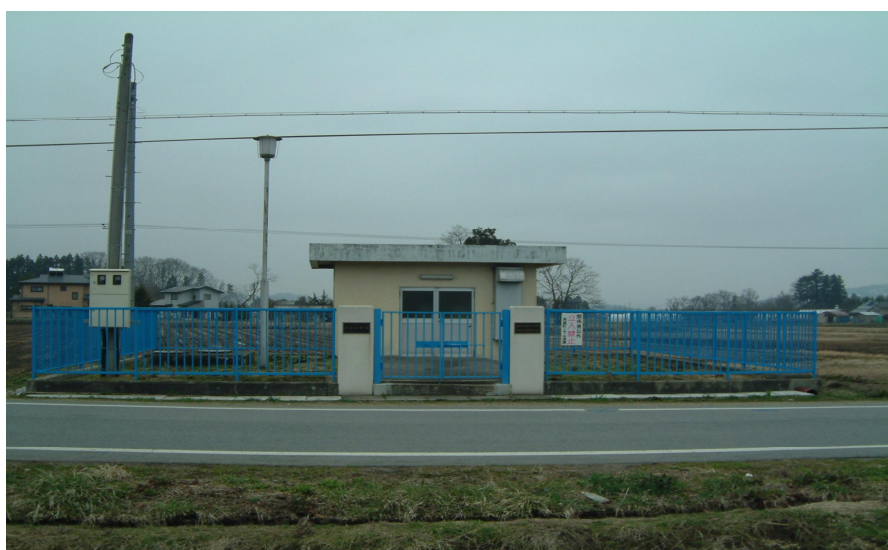
和田第2水源地
