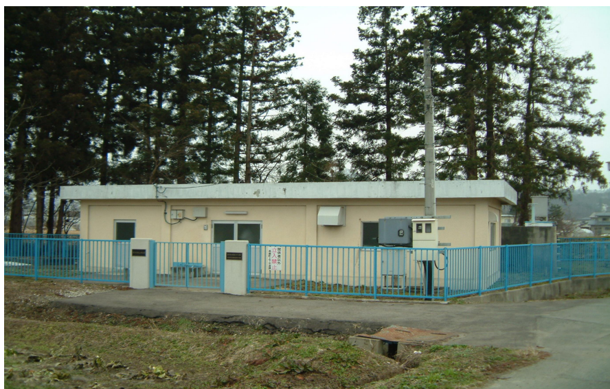
和田第1水源地
