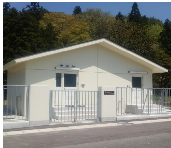
上和田第2送水ポンプ場
