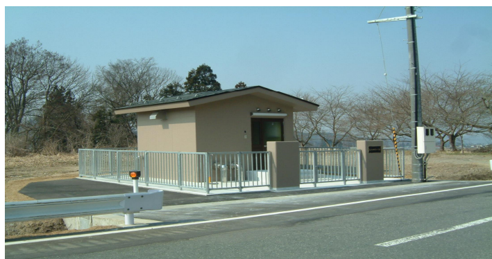
北和田ポンプ場
