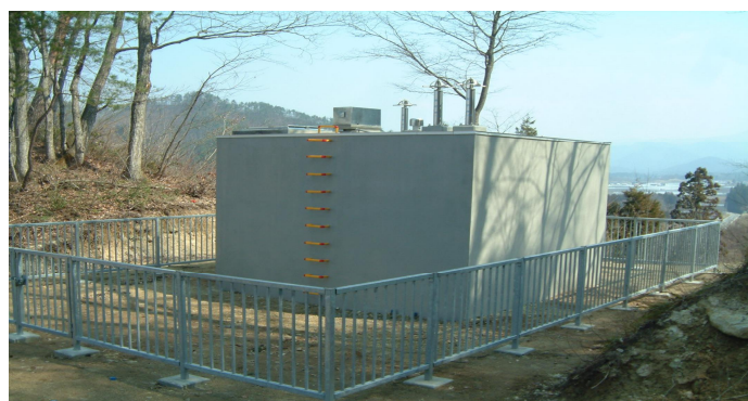
下海上配水池
