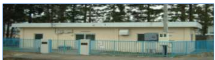
和田簡易水道 第1水源地
