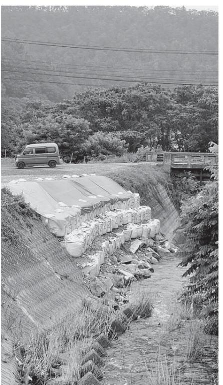
▲平成25年7月の豪雨による護岸崩落
