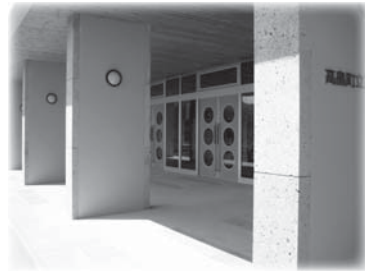
▲校舎東側 生徒昇降口
