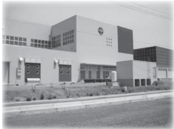
▲校舎西側 体育館棟
