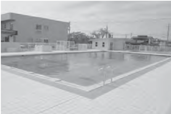
▲糠野目小学校プール
