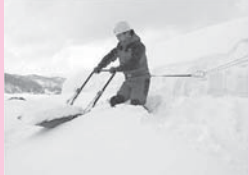
安全な雪下ろし作業例
