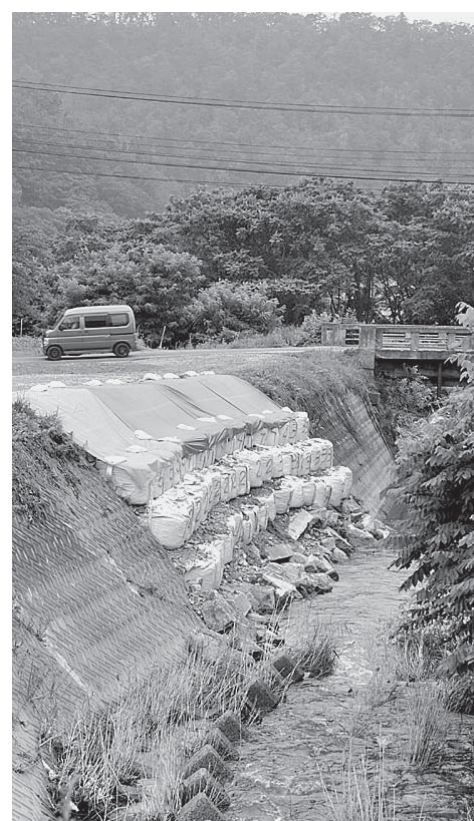
▲平成25年7月の豪雨による護岸崩落 ▶氾濫危険水位に達した吉野川
