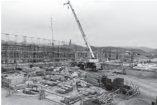
▲建設中の高畠中学校（仮称）
