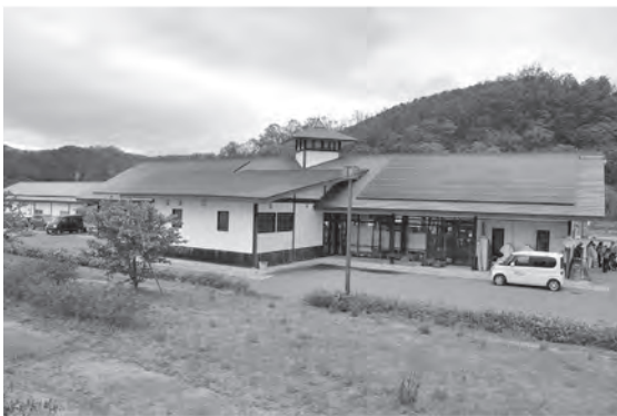
▲道の駅たかはたの太陽光発電設備
