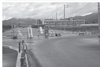
新設される飯森交差点工事
