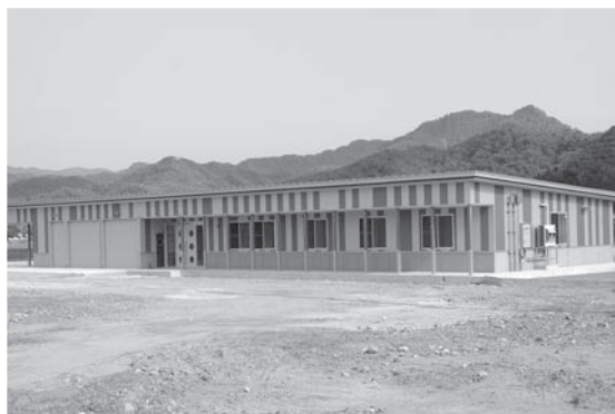
▲町防災拠点施設
