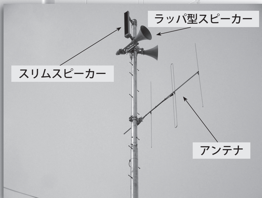
＜屋外拡声スピーカーの設置例＞ スピーカーの種類や個数は場所によって違いがあります。
