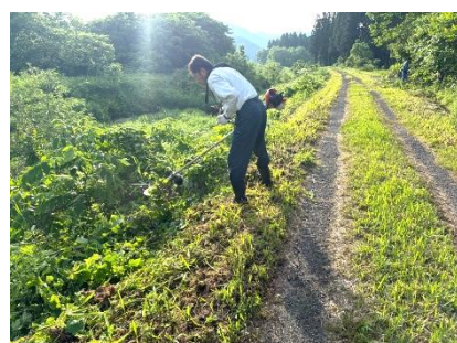
金谷橋上流作業風景
