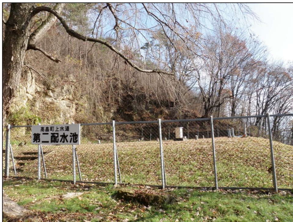
第2配水池(昭和31年築造)
