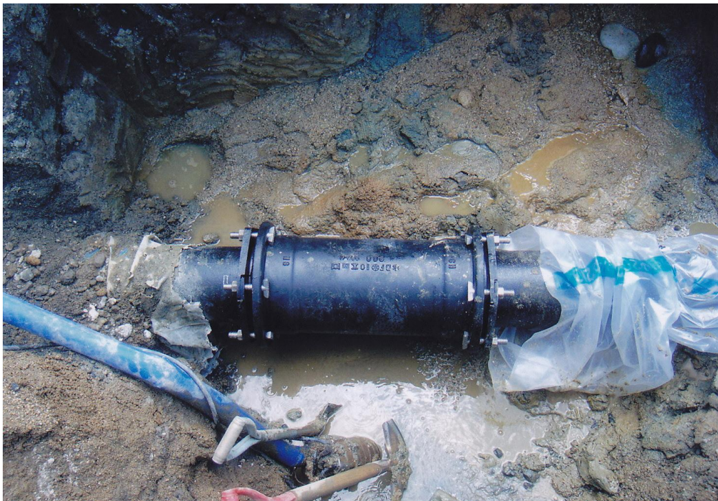
配水管布設状況 (DIP-NS φ200)
