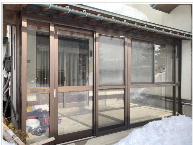
外観② ※玄関風除室
