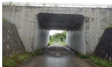
【川沼第2立体交差】
