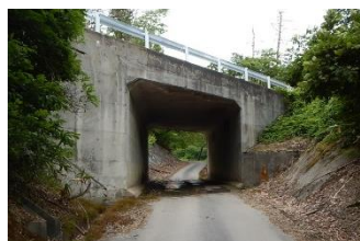
【向山立体交差】
