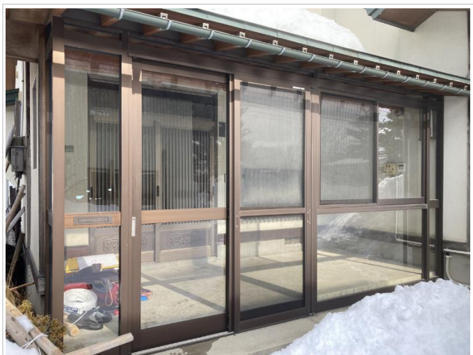
外観② ※玄関風除室
