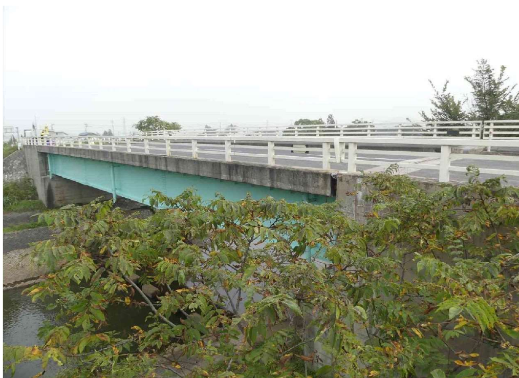
(H25 補修後の和田川橋)
