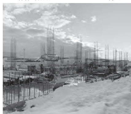
1階柱配筋が立ち上がった様子
