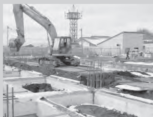
B工区基礎埋め戻し
