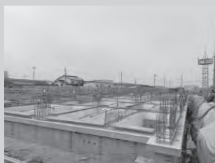
B工区基礎埋め戻し
