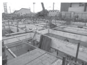
▲A工区基礎の様子
