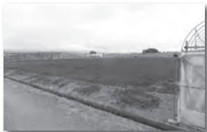
▲再生作業完了後
