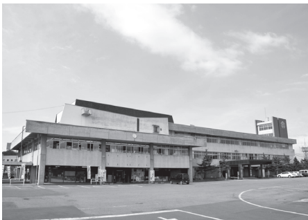
昭和43年に建設し、老朽化が深刻な現在の役場庁舎
